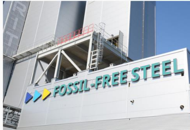
7 april 2021 – HYBRIT: SSAB, LKAB och Vattenfall bygger unik pilot för storskalig vätgaslagring för en kvarts miljard i Luleå SSAB, LKAB och Vattenfall påbörjar bygget av ett berggrumslager för fossilfri vätgas i pilotskala i...
